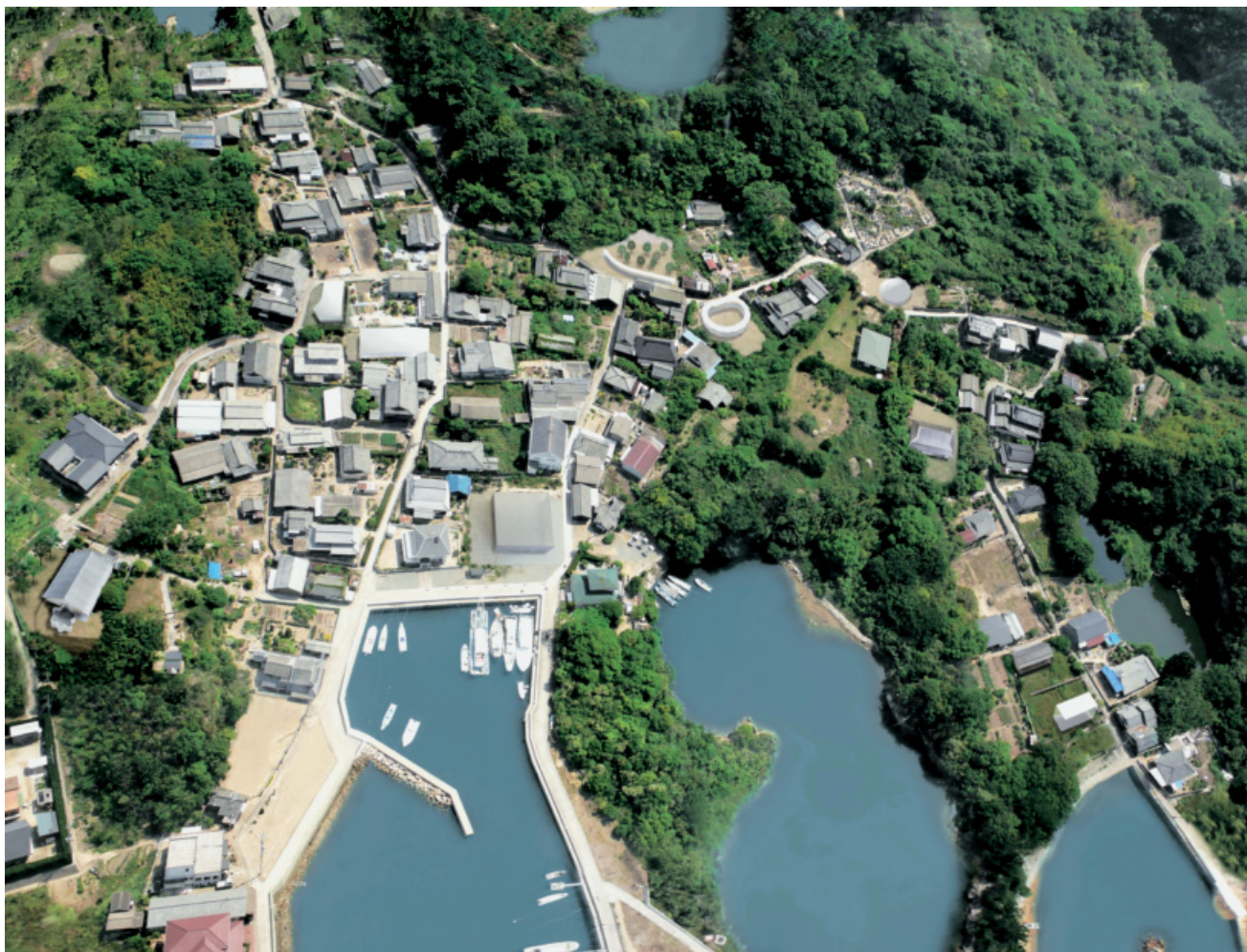
PABELLONES EXPOSITIVOS EN INUJIMA INUJIMA ART HOUSE PROJECT Inujima, Okayama, Japan, 2008/2010
