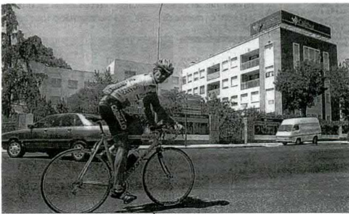
El antiguo sanatorio del Santo Ángel fue una de las obras sociales que creó Cajasar.
