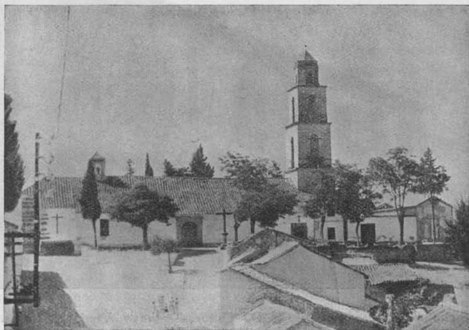
Vista general de la Ermita del Santo Cristo, como estaba antes de las obras que se le están haciendo actualmente.
